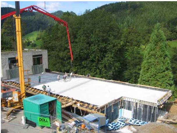
08.09.2006: die Sichtbeton-Decke wird gegossen / Casting of the fairfaced concrete ceiling
