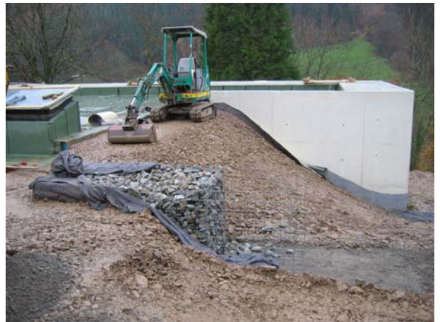
16.-21.11.2006: die Gabionen werden gesetzt / The gabions are put into place
