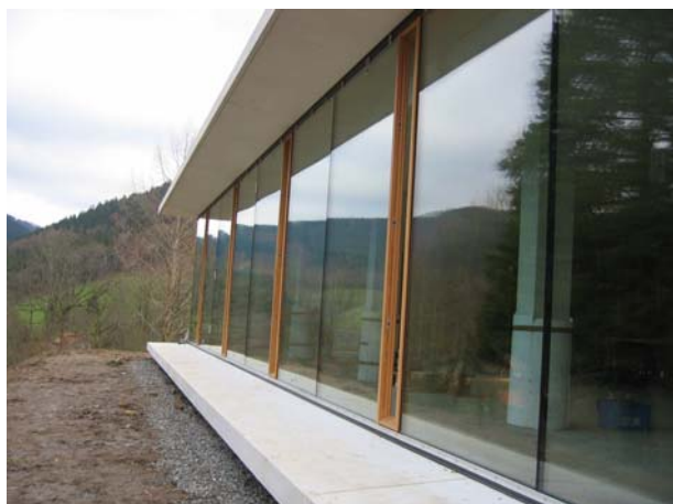
20./21.12.2006: die Fenster werden eingesetzt / Die Fenster werden eingesetzt / Installation of the windows
