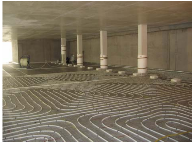
06.11.2006: die Fußbodenheizung wird verlegt / Installation of the underfloor heating
