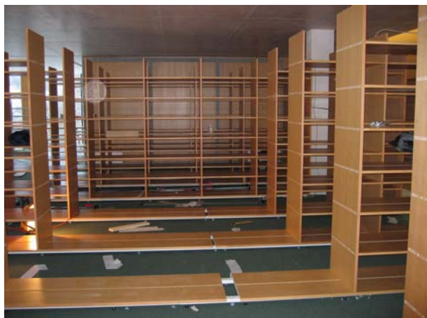
22. – 27.01.2007: die Regale werden montiert / Installation of the shelves
