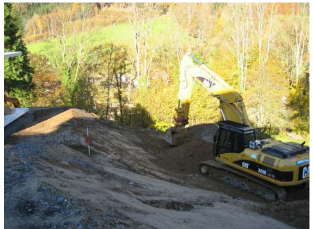
ab 08.11.2006: das Gelände wird für die Außenanlagen „anmodelliert“ / since 08.11.2006: Starting the modelling of the outdoor facilities
